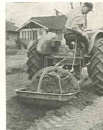
Standardtraktor med muldsluffe. Roterende jordbor til udgravning af huller for fundamentsklodser.
