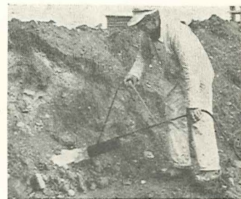
Optøning af jord med flammekaster.
