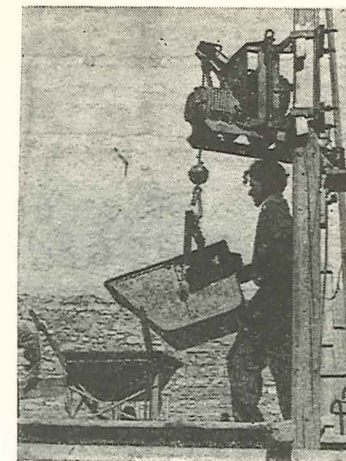
Etagekran, svingbar med elektromotor, anbragt på rejsebom af træ.
