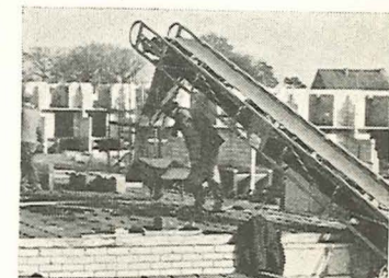
Transportbånd anvendt ved betontransport.
