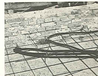
Ductube-slanger på forskallingen til etablering af kanaler for el-rør.
